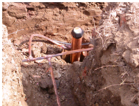
图(4) 在沟中布置的离子接地棒与水平接地体 b
