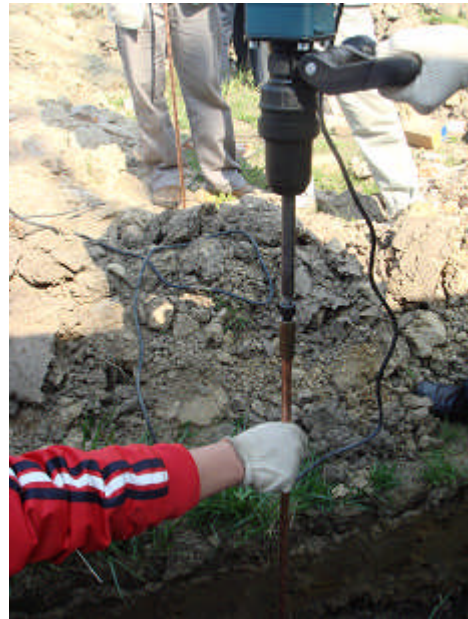
图（12）使用工具将新的接地棒打入地下
