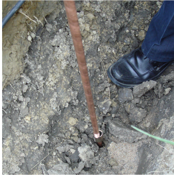
图（10）连接另一根接地棒 a
