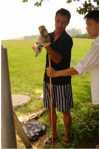
图（6）使用重锤施工
