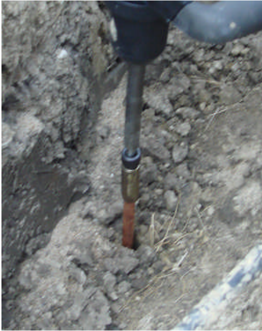
图（9）顶端距地面 20cm
