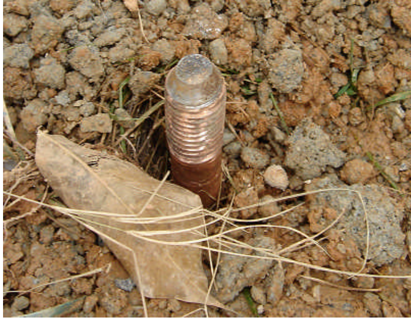
图（13）打入地下的接地棒
