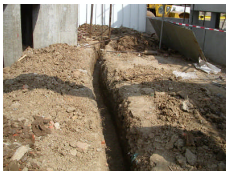
图(2) 挖沟的施工现场 b
