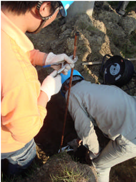
图（11）连接另一根接地棒 b
