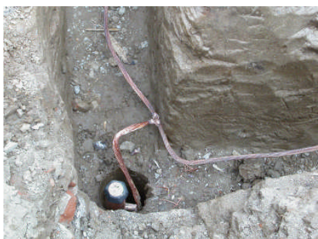
图(3) 在沟中布置的离子接地棒与水平接地体 a
