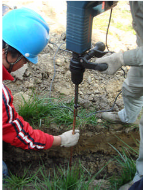
图（7）使用冲击电锤施工
