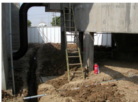
图(1) 挖沟的施工现场 a
