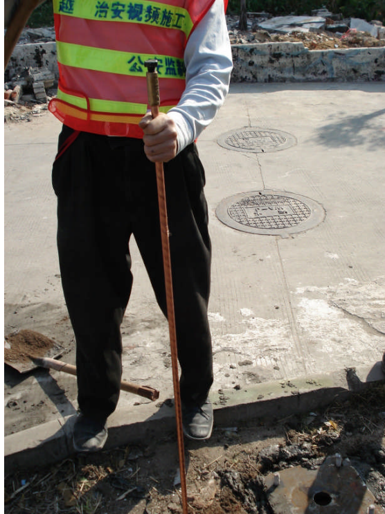
图（5） 接地极垂直放置
